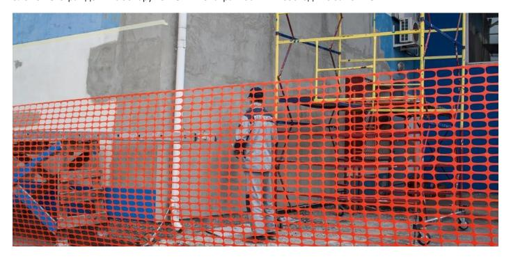
Применение временных ограждений на строительном участке регламентировано <u>ГОСТ 23407-78 Ограждение инвентарных строительных площадок и участков производства строительно-монтажных работ. Технические условия, а также СП 48.13330.2011 Организация строительства. Актуализированная редакция СНиП 12-01-2004 (с Изменением №1).</u>
